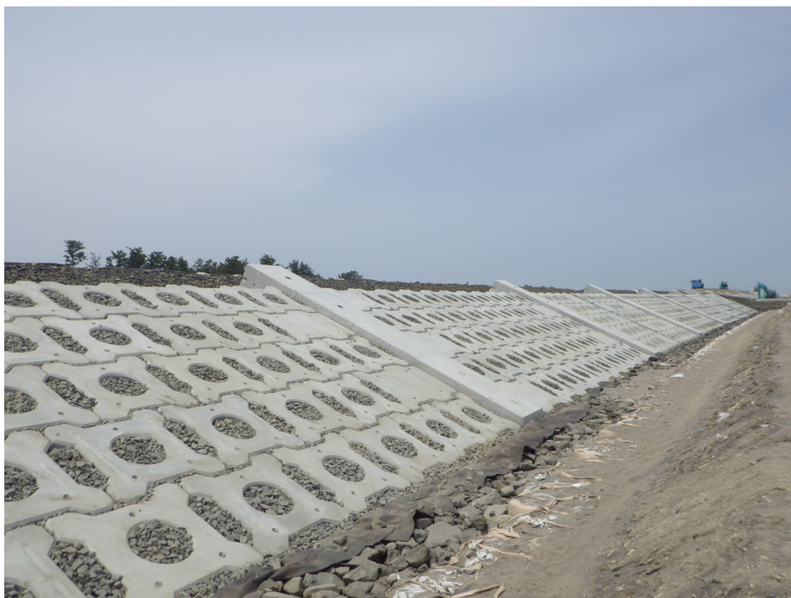
南部海岸蒲崎工区
