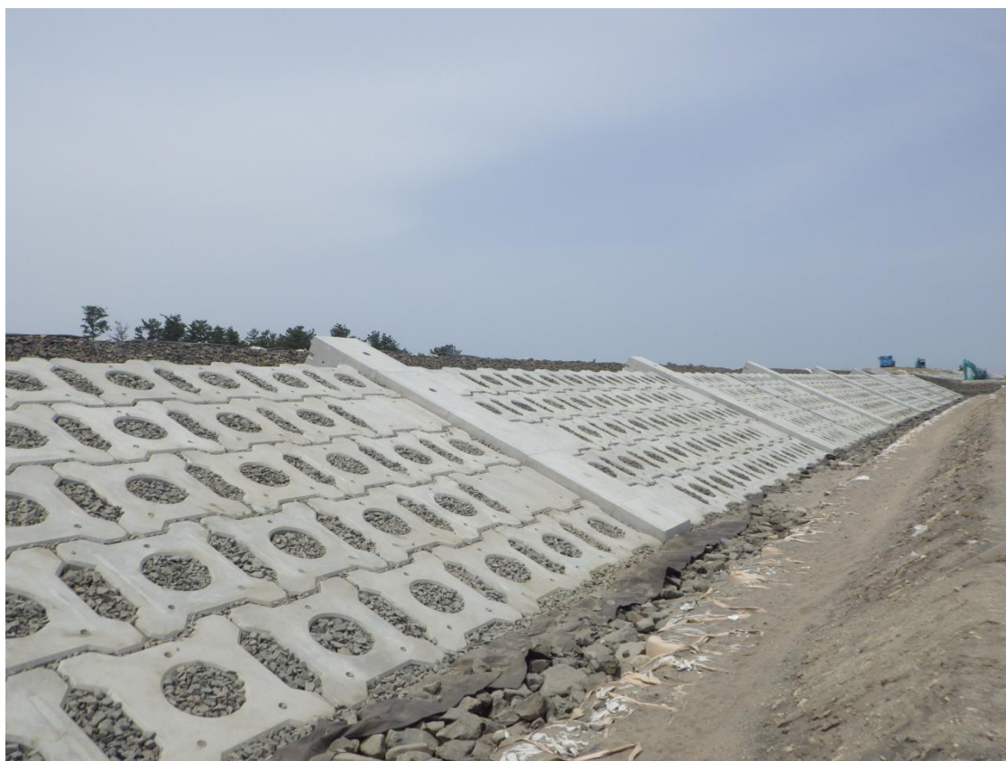
南部海岸蒲崎工区
