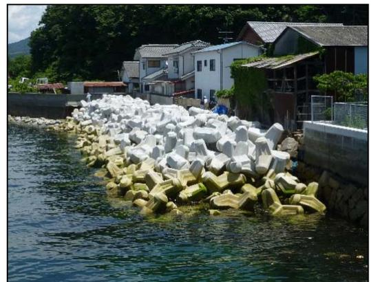
・全断面消波工法および二層被覆消波工法 (表-8)
