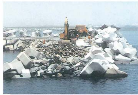
12. ガンマ・エル据付
