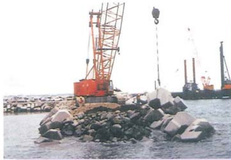
11. ガンマ・エル据付
