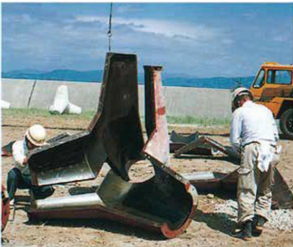
写真-28 シーロック型枠組立
