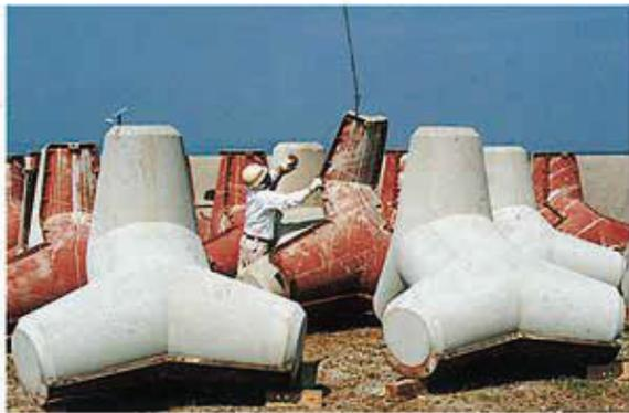
写真-40 側枠脱型
