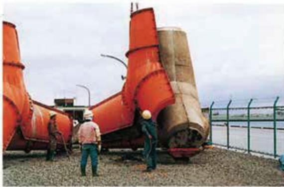
写真-39 側枠脱型
