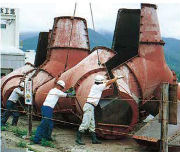
写真-29 シーロック型枠組立
