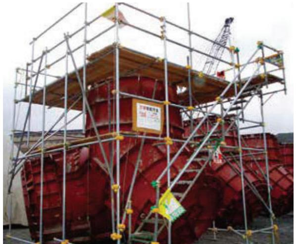
写真-32 シーロックB型型枠組立
