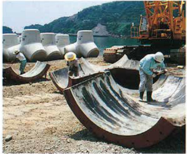
写真-30 シーロックB型型枠清掃
