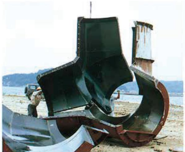
写真-31 シーロックB型型枠組立
